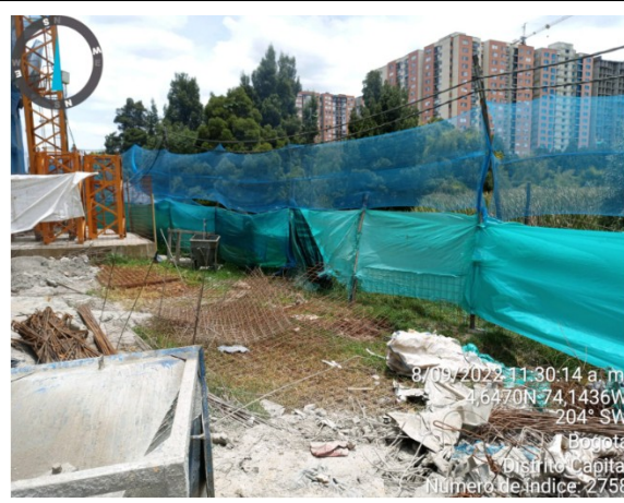
Fotografía No.2. Visita del 11 de julio de 2022. Afectación del cerramiento por almacenamiento de acero por el costado del humedal de Techo del Proyecto constructivo.
